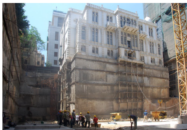
l'excavation sur 20 mètres
