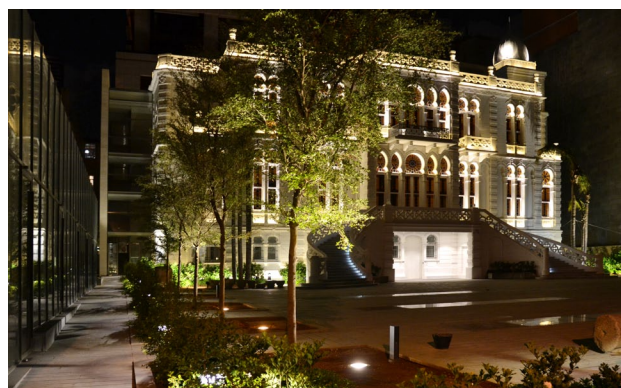
l'façade du bâtiment de nuit
