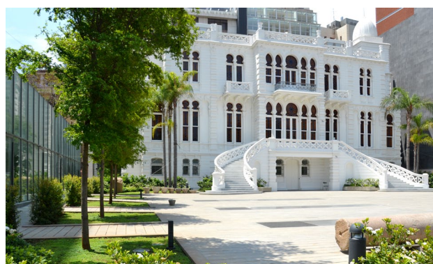
l'façade du bâtiment de jour
